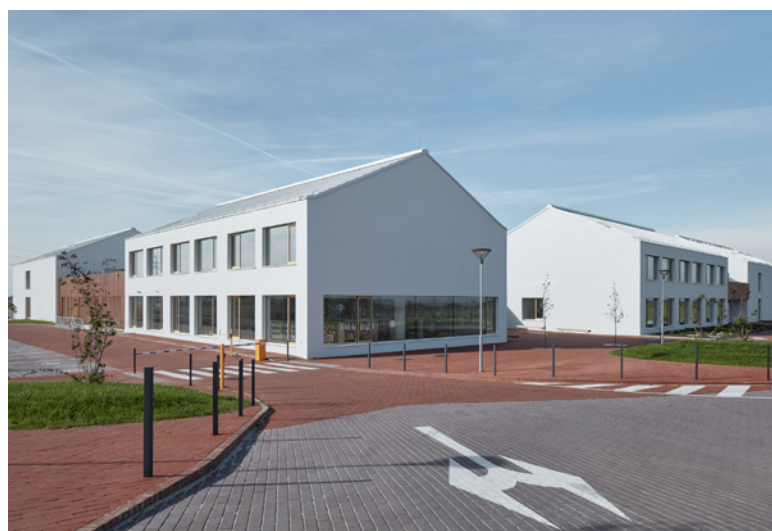
Základní škola Psáry byla dokončena jako budova mimořádně úsporná PENB A v pasivním standardu v létě 2019. Poměr A/V má 0,37, měrná potřeba tepla na vytápění 17 kWh/(m 2 .a). Celková potřeba primární energie je 61 kWh/(m 2 .a). Projekt: SOA architekti, s.r.o., Centrum NOVA, s.r.o., Dodavatel: PKS stavby a.s.
