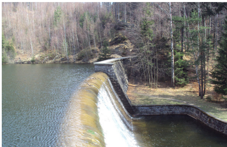
Zajímavým představeným vodním dílem je také průtočná nádrž Naděje v Lužických horách, která byla uvedena do provozu již v roce 1938 a v roce 2017 proběhla její rekonstrukce. (foto: Wikipedie, Zákupák, 2012)
