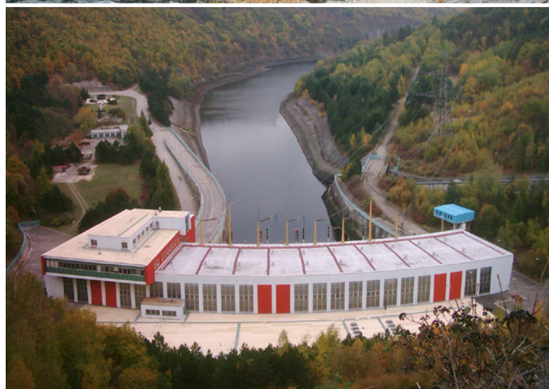
Jaderným reaktorem za hodinu proteče 42 000 m 3 vody. Jako zdroj technologické vody, především pro chlazení, slouží vodní dílo Dalesice (viz obrázek dole) společně s vyrovnávací nádrží, vodní nádrž Mohelno (viz obrázek nahoře). Dalesice zároveň fungují jako přečerpávací elektrárna (výkon 480 MW – dokáže v případě poruchy nahradit jeden blok jaderné elektrárny). Kapacita povodí a Dalesické přehrady by měla stačit i pro nové bloky s výkonem přes 1000 MWe. (foto: cs.wikipedia.org)
