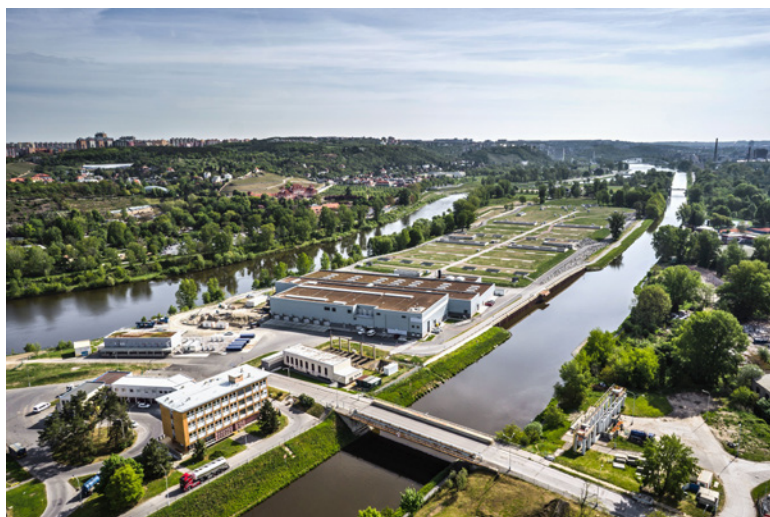
Pohled na celkovou přestavbu Ústřední čistírny odpadních vod v Praze na Císařském ostrově z roku 1968, která byla v letech 2015 až 2020 rozšířena o novou vodní linku. Nyní čistí přibližně 96 % odpadních vod hlavního města. (foto: ČKAIT, ČSSI)
