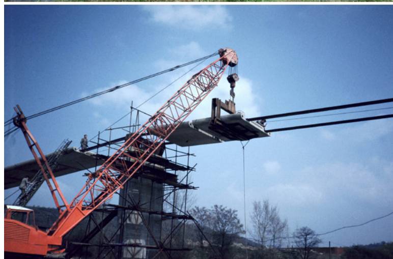
Fotografie zachycují výstavbu trojské lávky, která byla dokončena v roce 1984. (foto: archiv Jiří Stráský)
