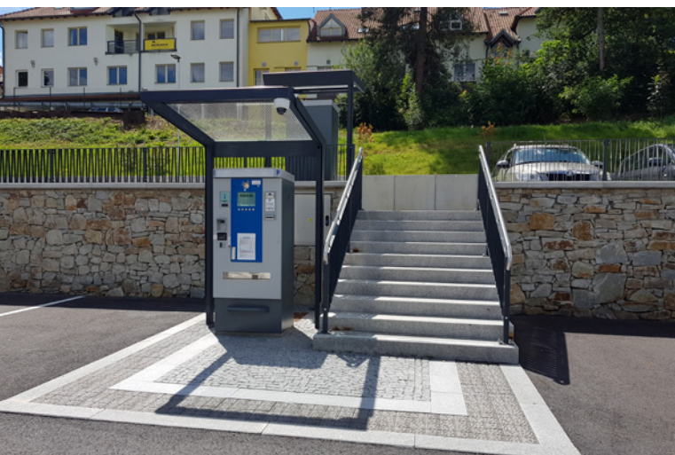
Zcela zbytečné použití hmatové úpravy varovného pásu na ploše parkoviště, kde není běžná pěší trasa (foto: archiv autora)
