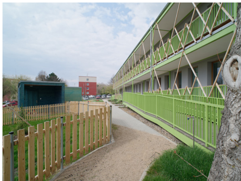
3. místo – Rekonstrukce mateřské školy ve Staré ulici v Ústí nad Labem (foto: Pavel Plánička)
