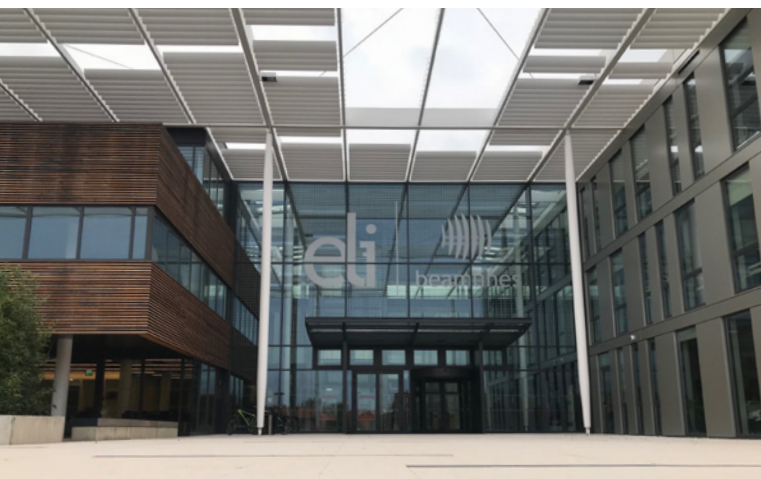
Investorem stavby laserového centra ELI Beamlines je Fyzikální ústav Akademie věd ČR, projektantem stavby je britská společnost Bogle Architects. (foto: Wikimedia Commons, Martin2035)
