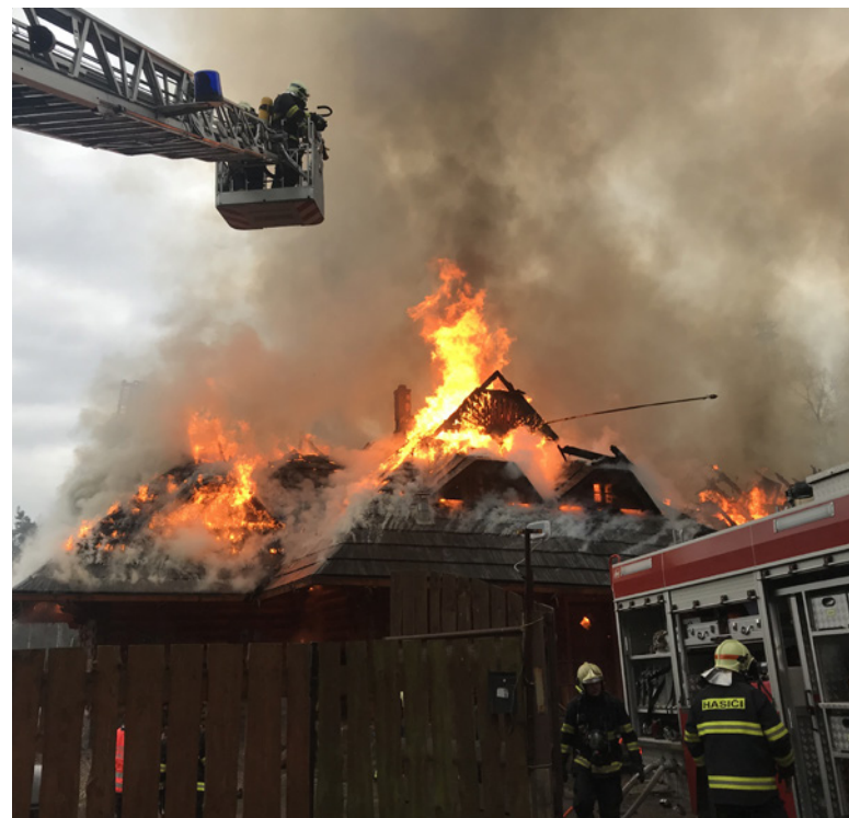
Pro rodinné domy by podle nově rekodifikovaného stavebního práva mělo stačit zpracovat požárně bezpečnostní řešení podle zjednodušeného manuálu. (zdroj: HZS)
