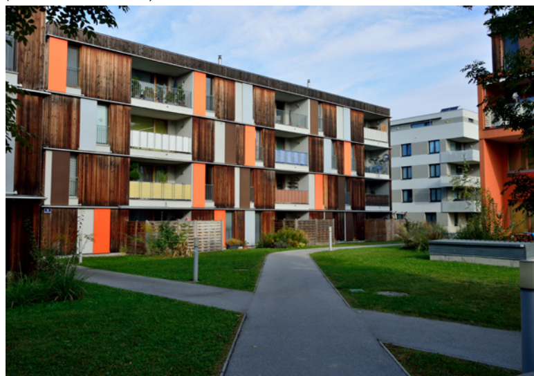
Bytové domy ve Floridsdorfu – pasivní dřevostavby po 15 letech provozu (foto: Jaromíra Škublová)
