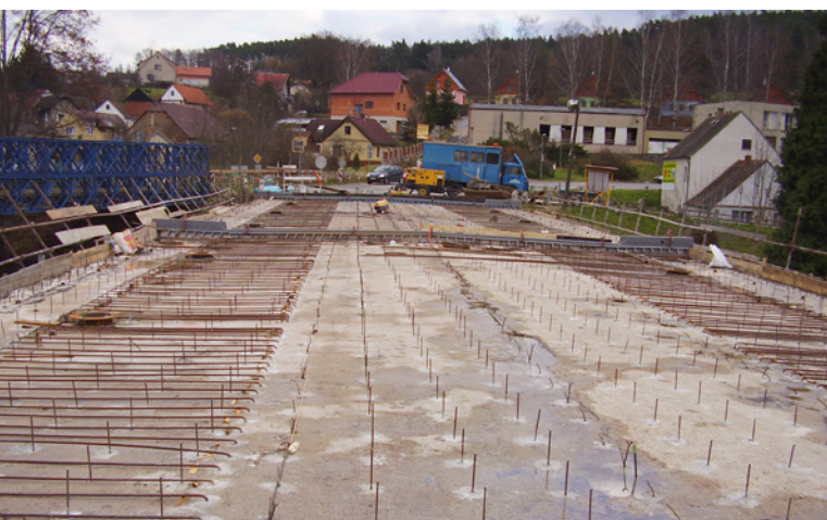
Oprava svršku a izolací komůrkového mostu (foto: František Košán)
