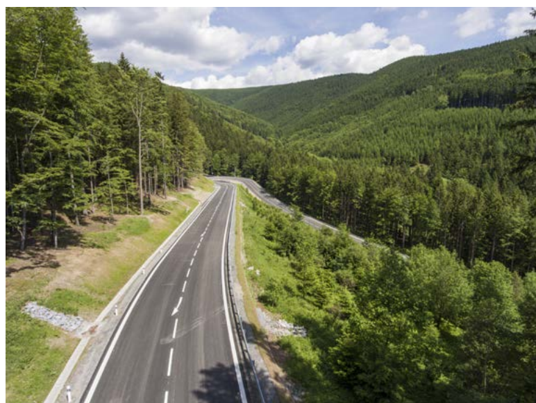
Rekonstrukce silnice I/44, Červenohorské sedlo – jih (foto: Metrostav, a.s.)
