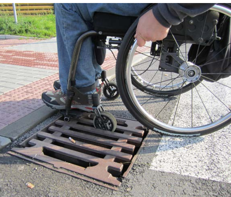
Neakceptování požadavku neumísťování kanalizační vpusti v ploše přechodu (foto: Ing. Renata Zdařilová, Ph.D.)
