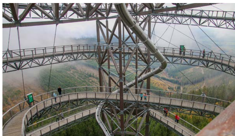
11. setkání na hranici bylo zakončeno sobotní odbornou exkurzí na ocelovou konstrukci Stezky v oblacích na Dolní Moravě s odborným výkladem projektantů. (zdroj: oblast ČKAIT Ostrava)
