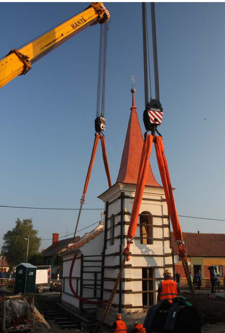
Po protažení příčniců z ocelových nosníků HEB 260 byly pod tyto vloženy 2 ks podélných ocelových nosníků HEB 260 délky 9 m, za které byla kaple zvednuta a přemísťována. Odtržení od základové spáry a vyzvednutí bylo provedeno pomocí dvou jeřábů LTM 1300 a LTM 1500. (zdroj: oblast ČKAIT Brno)
