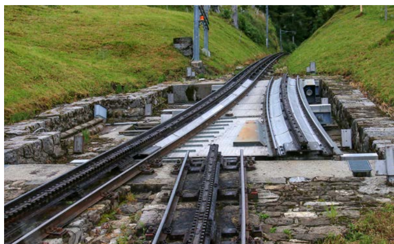
Originální výhybka na ozubnicové dráze na Pilatus (zdroj: oblast ČKAIT Ostrava)
