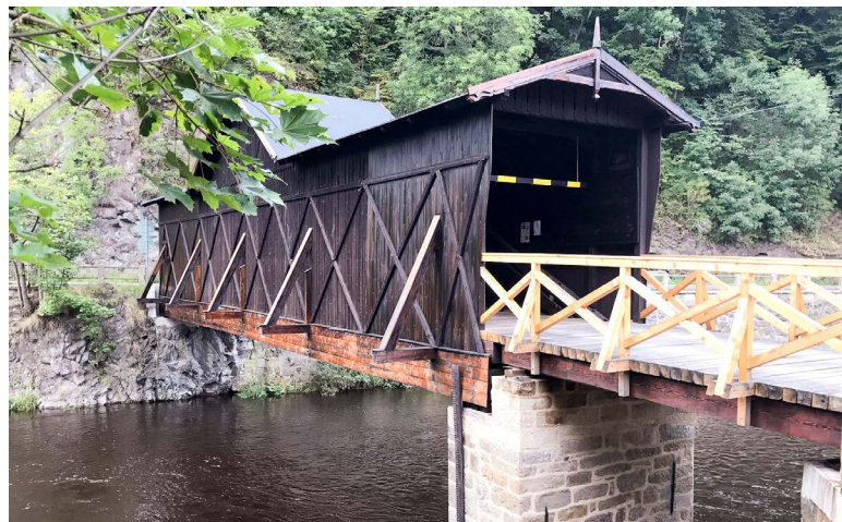
Dřevěný krytý most přes Jizeru v obci Bystrá nad Jizerou
