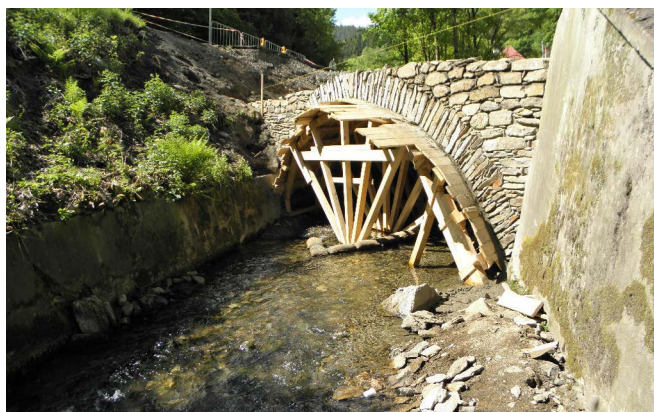
Oprava mostu přes Jáchymovský potok
