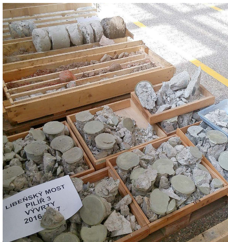
Zkoušky betonu potvrdily jeho velmi špatný stav a nízkou únosnost. Použitý beton byl míchán v poměru 200 kg cementu na m^3 a byl nedostatečně hutněn dusáním. (foto: Jakub Heller pro iDNES.cz)
