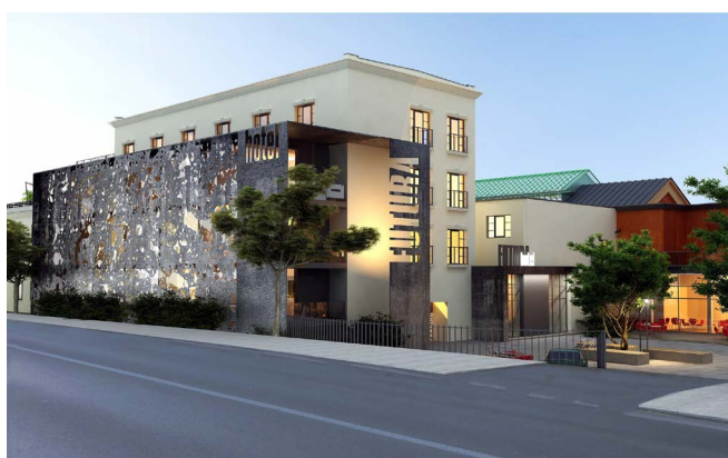
FUTURA – nová vodárna
