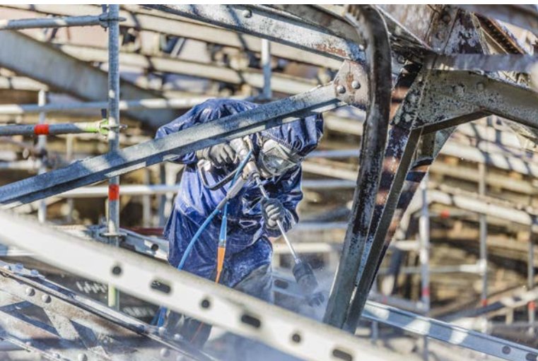
Hlavní Cenu Inženýrské komory 2017 získala Rekonstrukce ocelové konstrukce zastřešení nástupišť na Hlavním nádraží v Praze. (zdroj: EXCON, a.s.)
