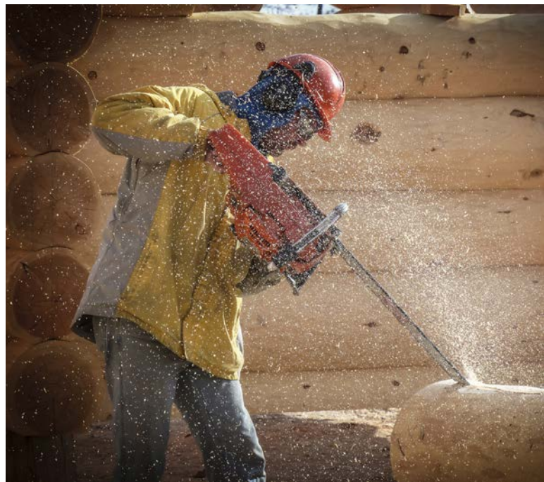
S řetězovou pilou se pracuje i na staveništi. (zdroj: pixabay.com)
