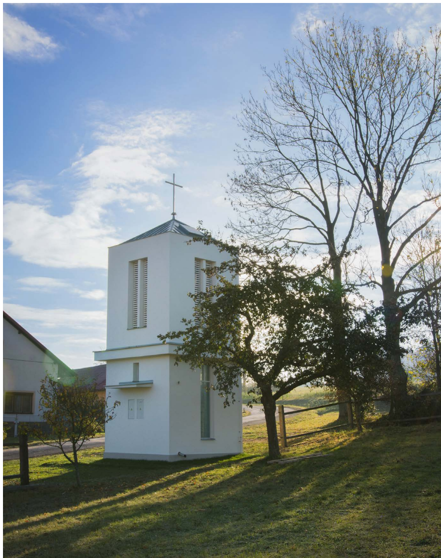
Obecní kaple se zvonící Mladoňovice – Deblov vznikla adaptací bývalé trafostanice a získala Cenu veřejnosti v rámci soutěže Stavba roku Pardubického kraje 2017.
