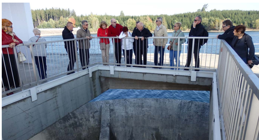
Účastníci exkurze nad bezpečnostním šachtovým přelivem vodního díla Želivka-Švihov (foto: Jan Mašek)
