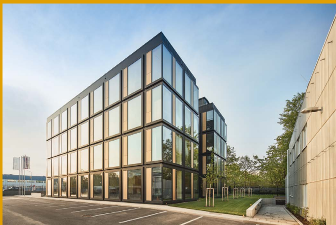
Administrativní a vývojové centrum firmy ERA – Stavba roku v kategorii Stavby pro průmysl, zemědělství a vodní hospodářství
