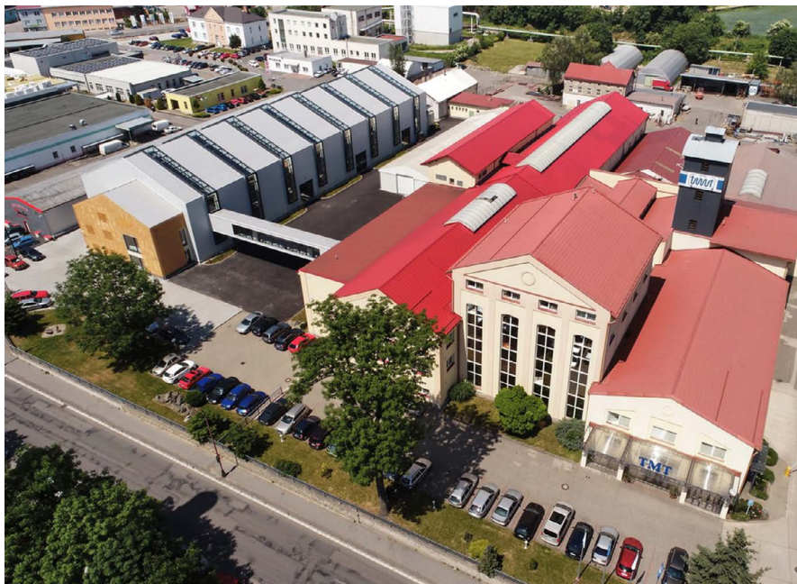
Nová montážní hala TMT spol. s r.o., Chrudim byla oceněna čestným uznáním v rámci soutěže Stavba roku Pardubického kraje 2017. Porotu zaujala návaznost na stávající průmyslovou zástavbu.
