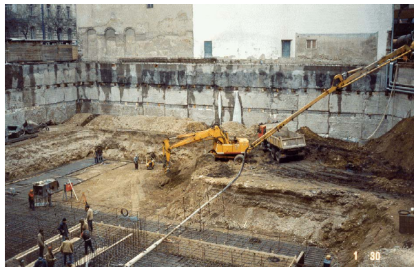
Obr. 2 Časť stavebnej jamy pre garáž Opera so stabilizačnými klinmi a armatúrou základovej dosky pod štvrtým podlažím
