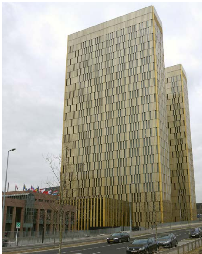
Budova Soudního dvora EU v Lucemburku (foto: CC0 Tercer, Wikipedia.org)
