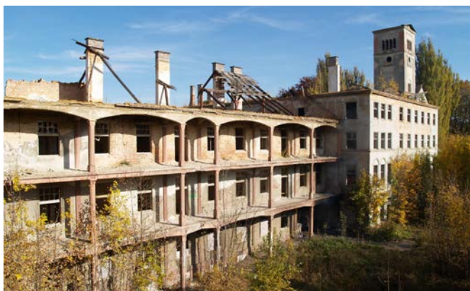
Změny ve stavebním zákoně oslabují ochranu veřejných zájmů na úseku státní památkové péče ..... 15
