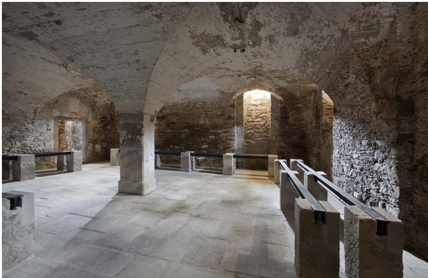
Současný stav podzemí kláštera premonstrátů Teplá (foto: Jan Borecký)
