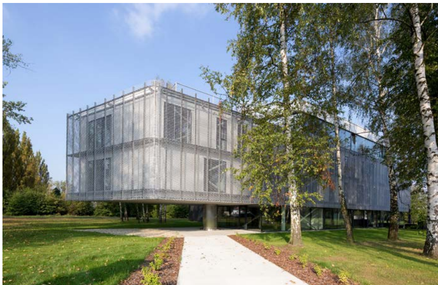
Čestné uznání v kategorii Průmyslové stavby získalo Aerozentrum v Mošnově. Zhotovitel: SIZO s.r.o.; návrh: Kamil Mrva Architects, s.r.o.; investor: Aero Invest, s.r.o.
