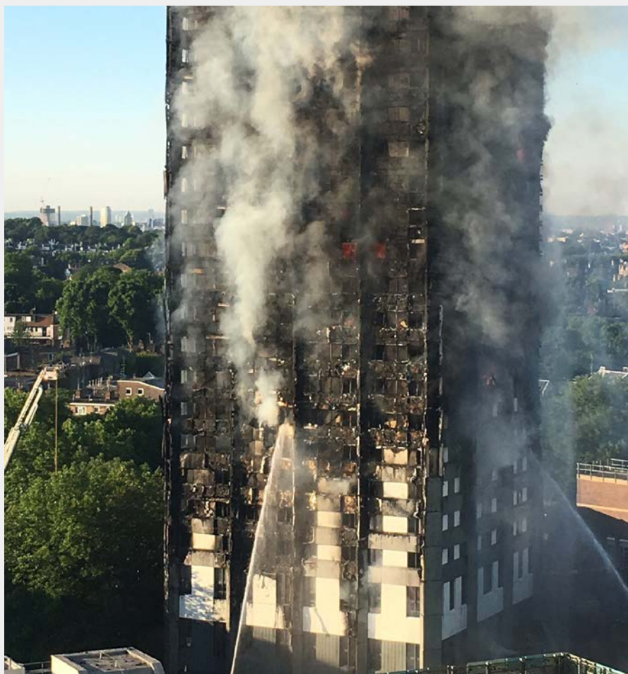
Zateplení budovy bylo hlavní příčinou ničivého požáru bytového domu v Londýně. Podrobnější informace si můžete přečíst v ESB 3/2017 na www.magazin-esb.cz (foto: Natalie Oxford, Creative Commons, CC BY 4.0 International, via Wikimedia Commons)
