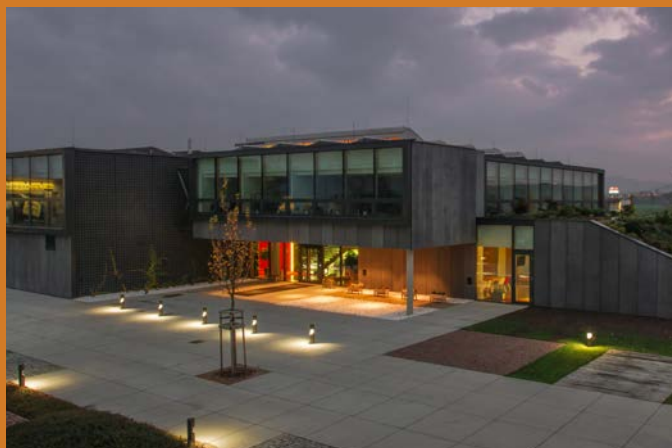
Firemní sídlo společnosti Lumius ve Sviadnově získalo hlavní cenu v kategorii Průmyslové stavby
