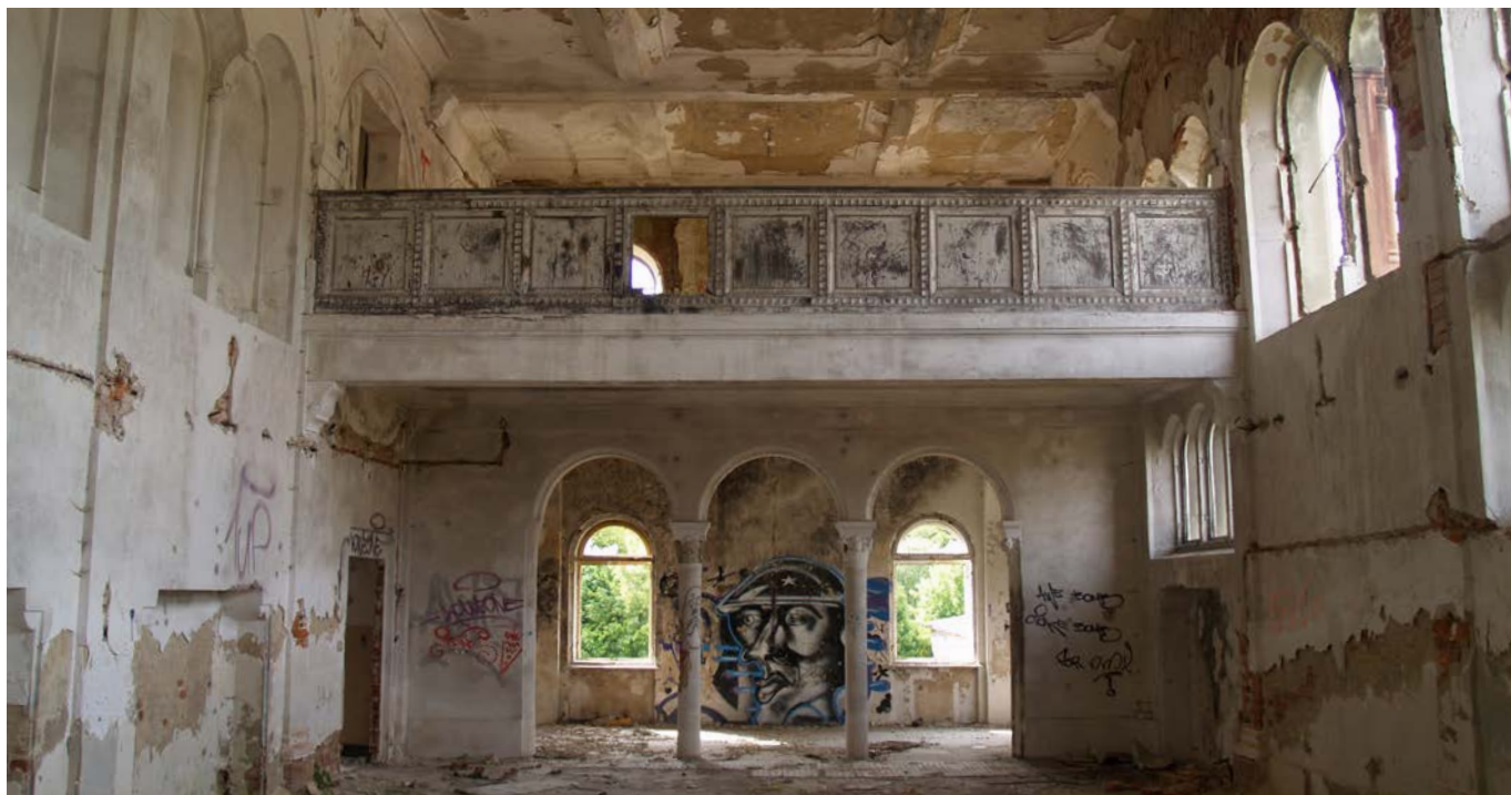
Kláster Kongregace milosrdných sester sv. Kříže v Chebu byl postaven v roce 1930. Stavbu v roce 2005 koupila turecká společnost Beta Energy Investment s.r.o. s cílem vybudovat zde kasino. V říjnu 2016 byla již celá kulturní památka srovnána se zemí. Zplanyrovaný pozemek nabízí turecký majitel k prodeji. Vyměřená pokuta za likvidaci kulturní památky byla pouhých 20 000 Kč (foto: Národní památkový ústav, územní odborné pracoviště v Lokti).
