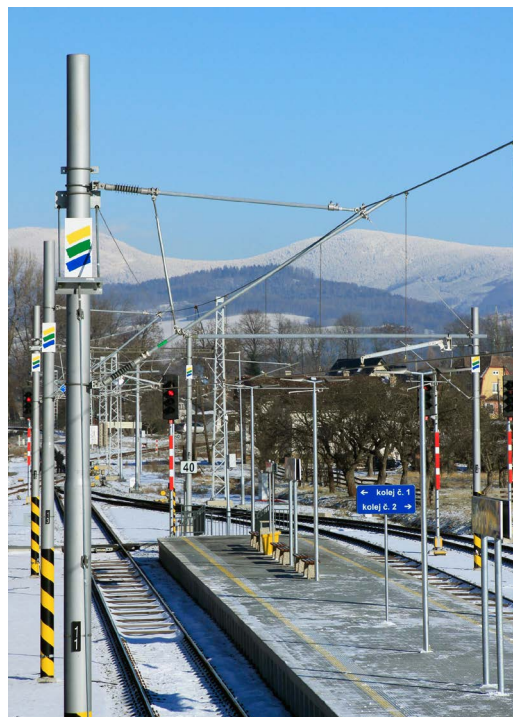
Revitalizace trati Bludov – Jeseník byla oceněna Čestným uznáním v kategorii Stavby dopravní, inženýrské a vodohospodářské
