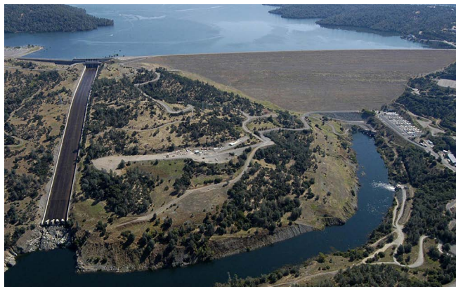
Pohled na přehradu Oroville před letošní událostí (foto: California Department of Water Resources)
