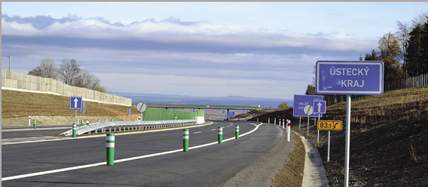
Nedávno otevřený úsek dálnice D6 u Lubence, zprovozněný 10. listopadu 2015. Součástí stavby jsou tři mosty a přeložky ostatních silnic v délce 2884 km. (foto: Štěpán Sedláček, RoadMedia s.r.o.)
