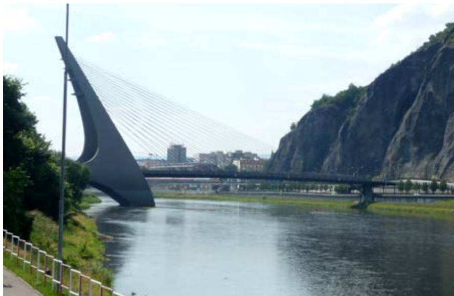
Mariánský most přes řeku Labe byl oceněn v architektonických soutěžích, dopravní napojení na levém břehu ve směru do centra však není vyhovující
