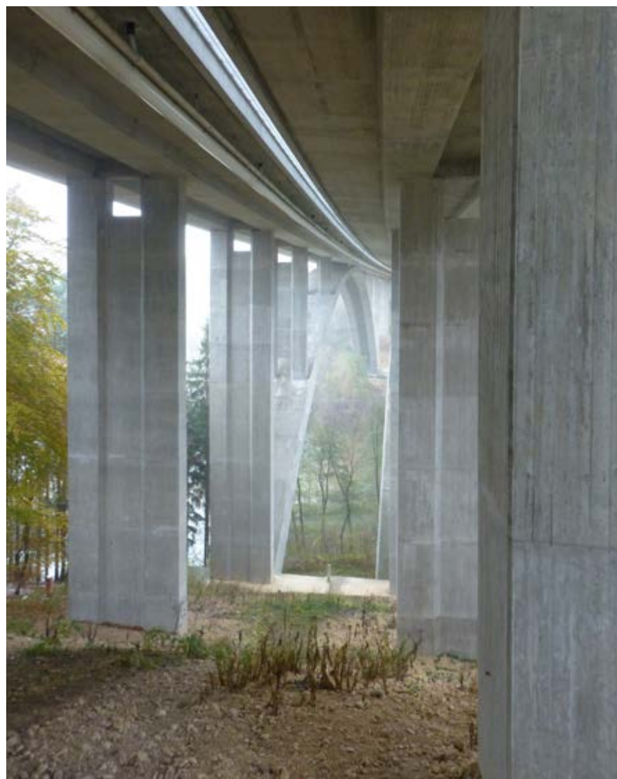
Most přes Opárenské údolí na dálnici D8 patří mezi největší obloukové mosty. Délka 275 m, rozpon oblouku 135 m. Zodpovědný projektant: Ing. Milan Kalný, Ing. Václav Kvasnička, PONTEX, s.r.o., dodavatel stavby: METROSTAV a.s., dokončení: 2010, foto z jara 2016.
