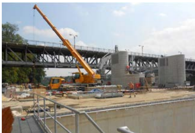
Malá vodní elektrárna (MVE) Roudnice nad Labem – Vědomice o max. hltnosti 225 m³/s. Součástí byla i výstavba kanálu pro vodní slalom a rybí přechod. Dokončení 2015.
