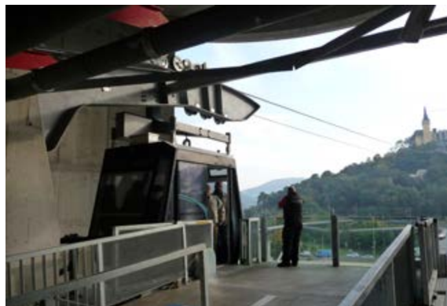
Nejdelší visutá lanovka v ČR z OC Forum na Větruší, délka 330 m, kapacita 390 osob/hodinu. Dokončena 2010. Zhotovitel: Viamont DSP.
