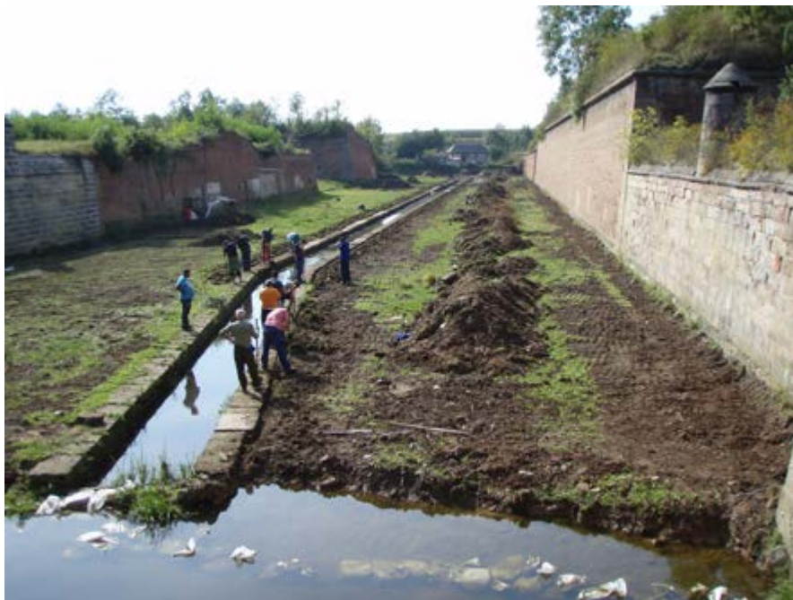
Terezín, protipovodňová opatření (dokončení 2016) a dosud probíhající rekonstrukce pevnosti. Délka ochranné hráze 2143 m, mobilní stěny 300 m. Dodavatel: Pražské silniční a vodohospodářské stavby, GEOSAN GROUP a.s., Navimor-Invest, S.A., celkové náklady 139,5 mil. Kč
