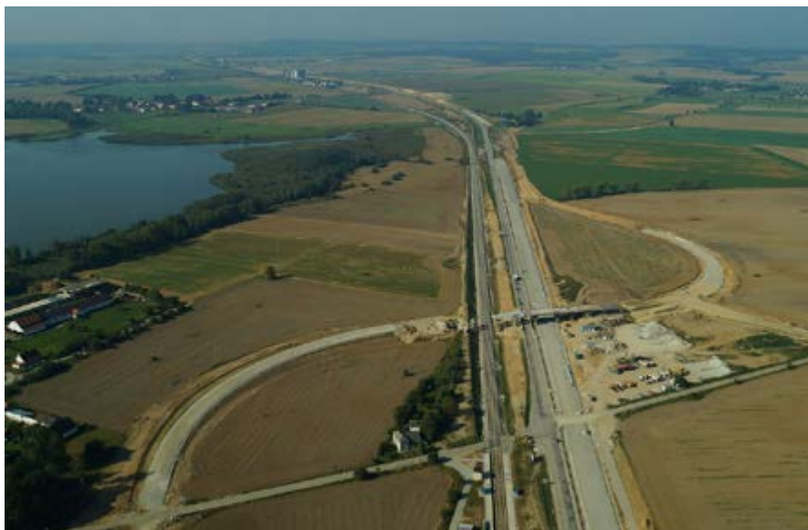
Při odborné exkurzi se účastníkům nabídl pohled z horní plošiny sila na rozestavěnou část D3 v úseku Veselí nad Lužnicí – České Budějovice (foto: Ing. František Hladík)
