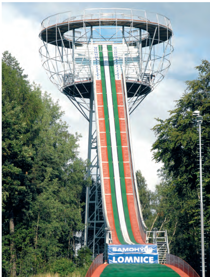
Skokanský můstek v Lomnici nad Popelkou se stal z pohledu veřejnosti stavbou roku Libereckého kraje v roce 2008
