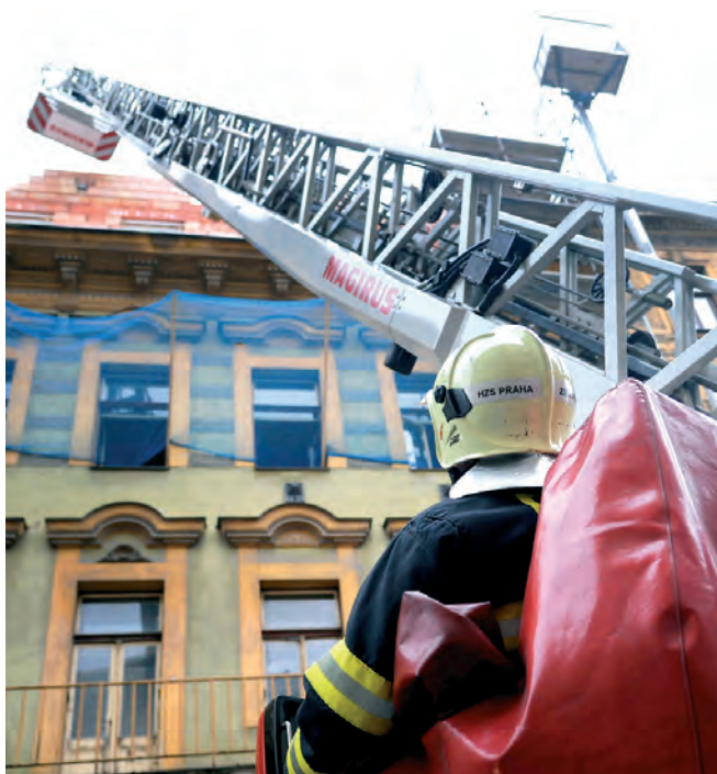
Po zřícení schodiště bytového domu v Praze byl obžalován stavbyvedoucí a další osoby ze spáchání trestných činů způsobení smrti, respektive těžké újmy na zdraví z nedbalosti (foto: HZS Praha)
