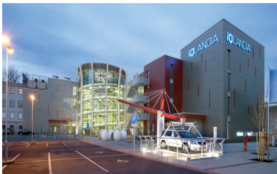
Centrum iQlandia získalo titul Stavba roku Libereckého kraje – Cenu doc. Ing. arch. Karla Hubáčka, dr. h. c., v roce 2014. Projektant: Ing. Jan Palas, dodavatel: EUROVIA CS a.s.
