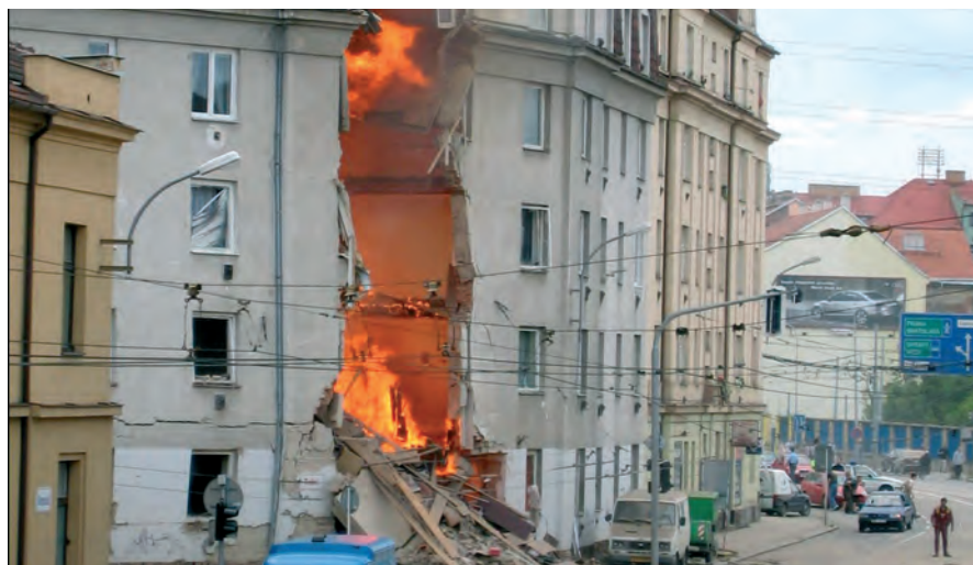
Výbuch plynu, požár a destrukce budovy v Brně, 21. června 2004
