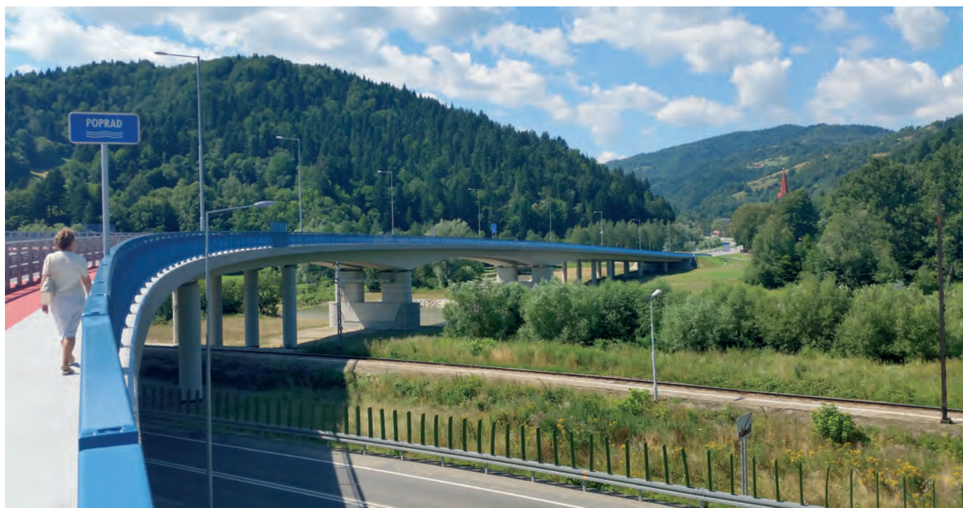
Hraniční most mezi Mníškem nad Popradem a polskou Piwniczną-Zdrój (foto: Svatopluk Bijok)
