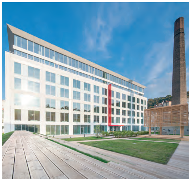
Administrativní budova Corso Court v pražském Karlíně byla projektována v BIM a dokončená v červenci 2015 (foto: Skanska)
