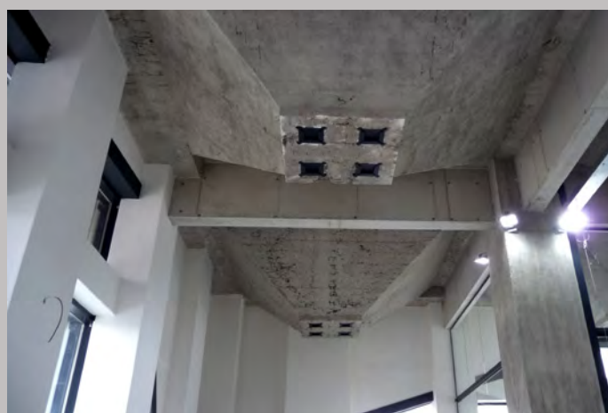
Vchod do konvertovaného síla ve Zlíně – Prštém, detail podhledového betonu (foto: archiv Ing. arch. Dagmar Nová)
