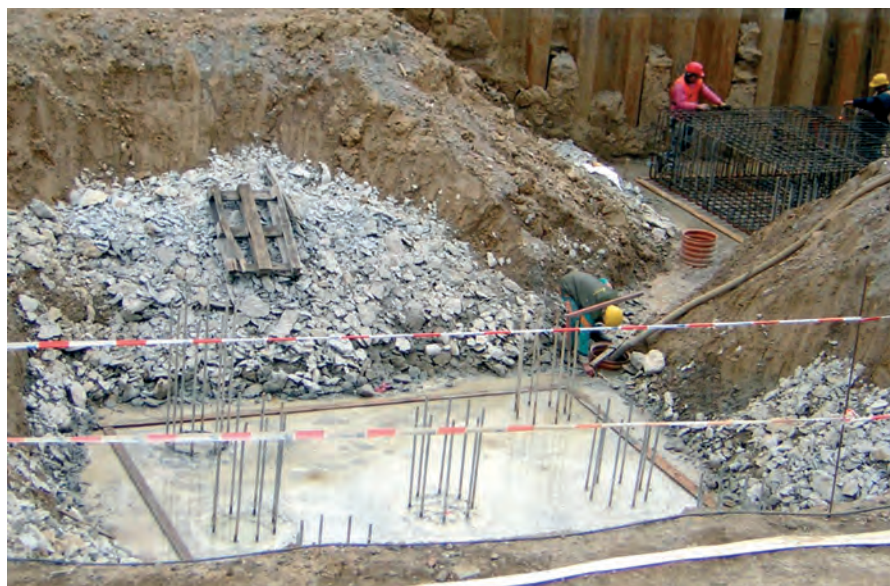
Při provádění zemních prací je třeba dodržovat bezpečnost práce (foto: archiv autora)
