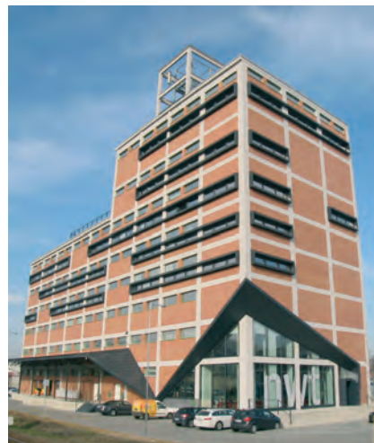
Obilné silo ve Zlíně – Prštném bylo konvertováno na administrativní budovu podle projektu Ing. arch. Ladislava Semely, zpracovatel projektové dokumentace: Centropjekt. Stavba byla dokončena v dubnu 2014.
