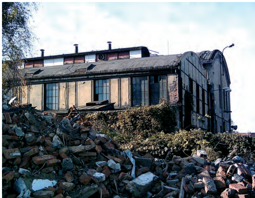
Třetímu největšímu skladu chloru v ČR měla sloužit budova z roku 1898 v obci Pchery, v geologicky nestabilním místě bývalého hlubinného černouhelného dolu Theodor
