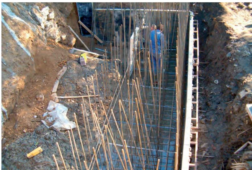
Do hloubky 5 až 6 m se realizuje vytěžení v jedné etapě (foto: archiv autora)
