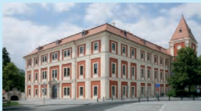
Rekonstrukce zámku Ostrov, 1. místo a Cena hejtmána v soutěži Stavba roku Karlovarského kraje
