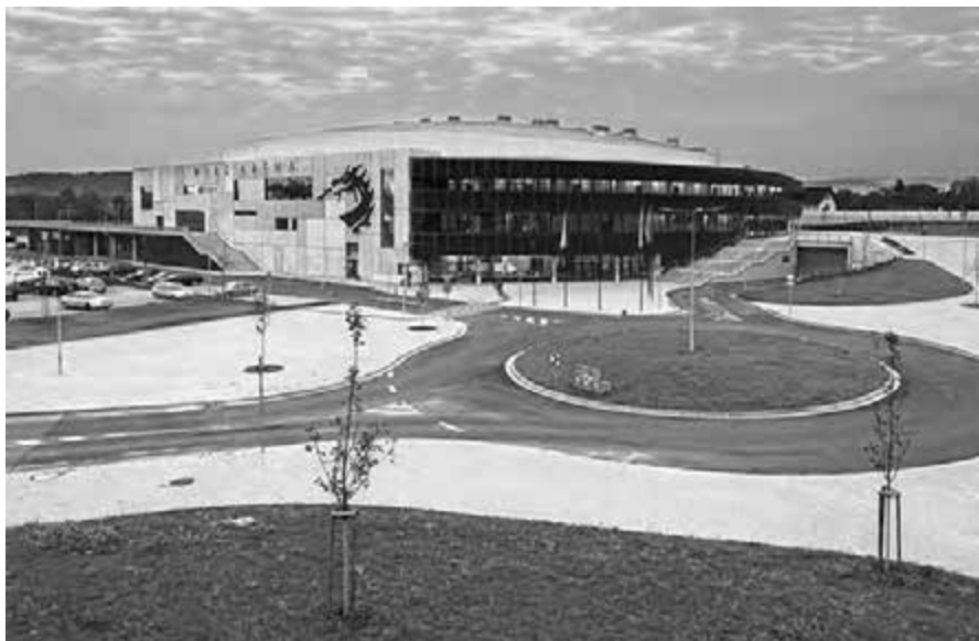
Víceúčelová hala Werk Arena, Třinec, získala hlavní cenu Grand Prix Stavby roku Moravskoslezského kraje a první cenu v kategorii Stavby občanské vybavenosti
