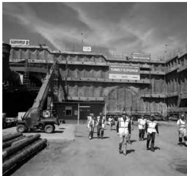
Účastníci exkurze před vstupem do tunelu
