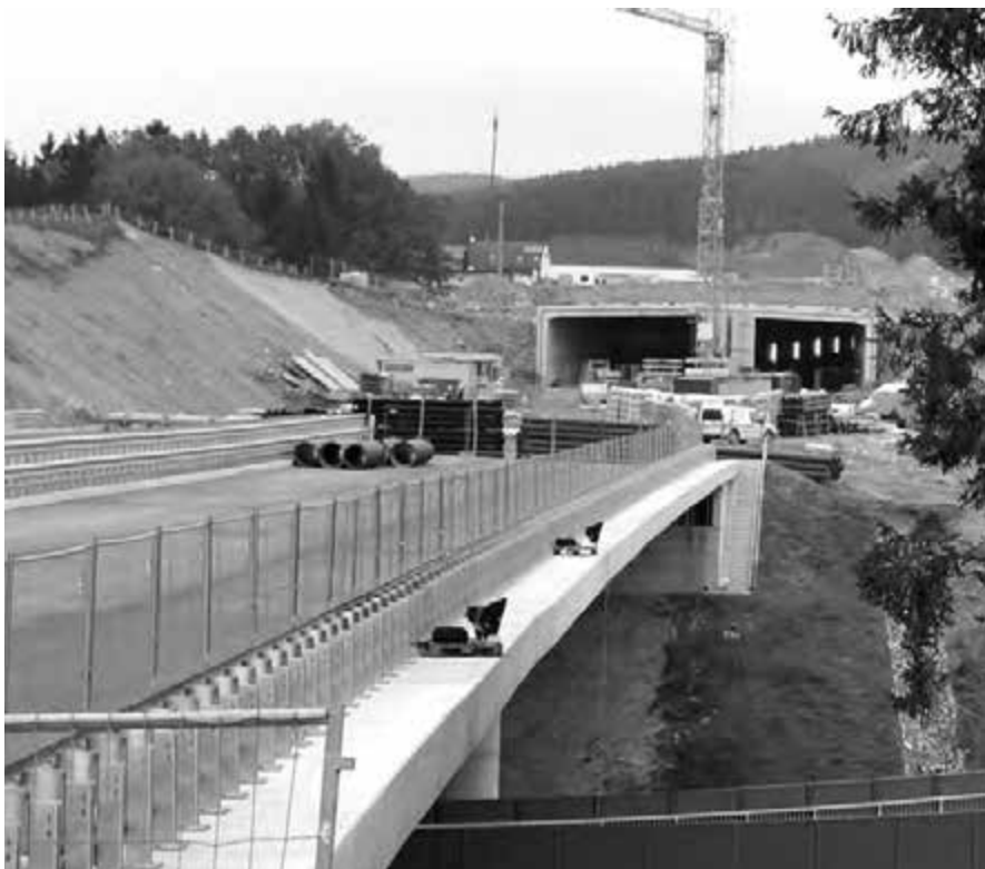
Snímek ze stavby S10 u Freistadtu – navazující část na naší dálnici D3 Praha–Linec
