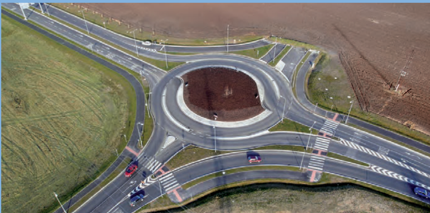
Přeložka silnic II/156 a II/157 – IV. etapa, České Budějovice, titul PRESTA v kategorii Dopravní a ostatní inženýrské stavby
