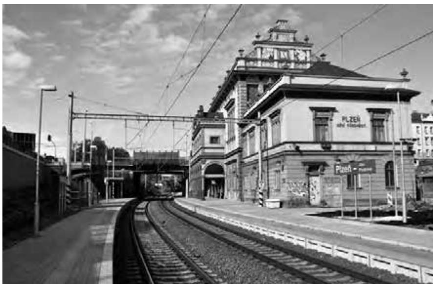
Průjezd uzlem Plzeň získal Cenu ČKAIT Plzeňského kraje. Na obrázku úprava nádraží Jižní předměstí.
