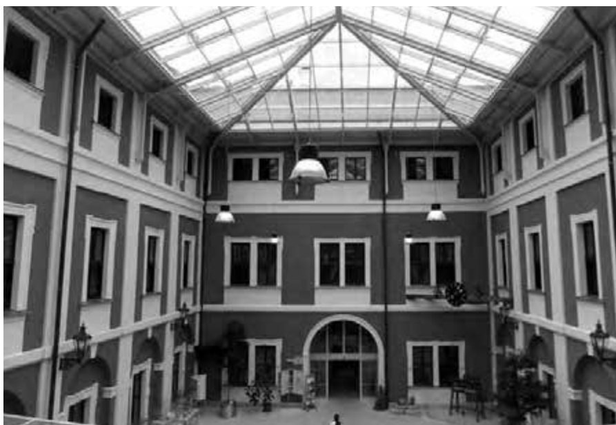
Rekonstrukce zámku Ostrov získala 1. místo za realizaci v soutěži Stavba Karlovarského kraje
