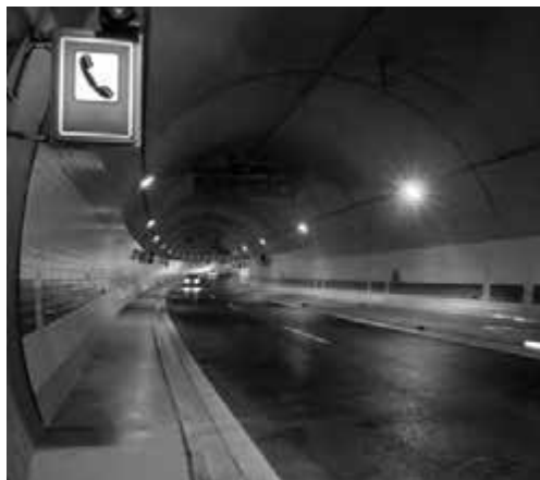
Nově otevřený tunel Blanka (foto: Metrostav a.s.)
