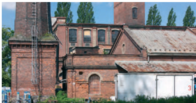
Průmyslové budovy jsou pamětí našich měst, na obr. prádelna Neumann ve Frýdku-Místku (foto: Lukáš Beran) . . . 32
