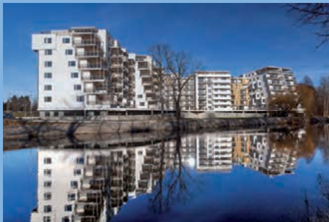
Rezidence Dlouhá louka, České Budějovice, titul PRESTA v kategorii Rodinné domy a bytové stavby
