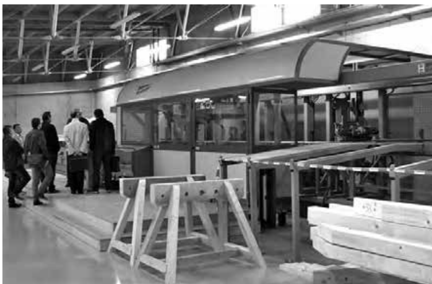
Automatická CNC linka instalovaná v nově otevřené učební a výrobní hale při SPŠ a VOŠ ve Volyni
