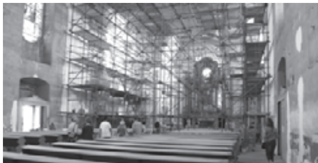
Interiér kostela sv. Anny v Sedleci – probíhající restaurátorské práce na výmalbě a štukové výzdobě (foto: Jan Borecký)
