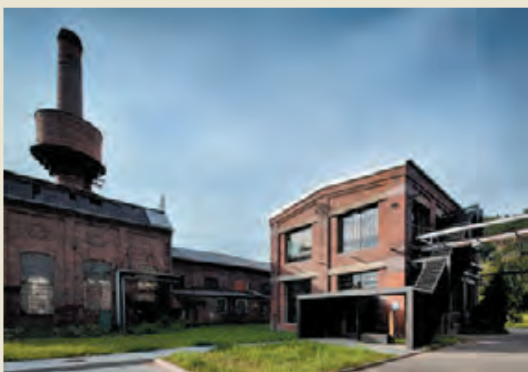
Uhelný mlýn, Libčice nad Vltavou (Atelier Hoffman – Ing. arch. Patrik Hoffman), cena za rekonstrukci industriálního objektu v soutěži Stavba roku Středočeského kraje 2013
