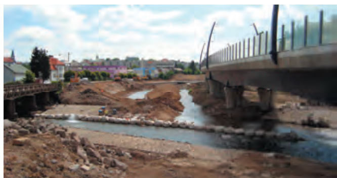
Oblast Brno na exkurzi technicky impozantního železničního uzlu v Ústí nad Orlicí . . . . . 27
