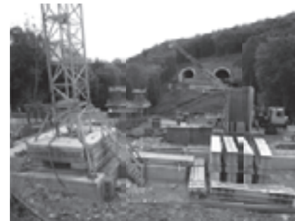
Rozestavěný most přes Uhelnou Strouhu mezi tunely Prackovice a Radečín
