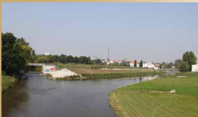
Ochranné hráze a úpravy v inundaci řeky Moravy pod mostem Velkomoravská; paralelní koryto Moravy a nový, asi 350 m dlouhý zelený ostrov významně zlepšil odtok při povodních.
