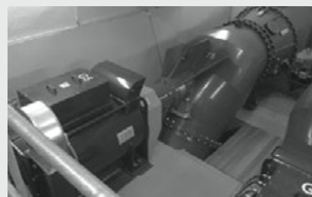
Moderní Semi-Kaplanovy přímoprůtočné turbíny
