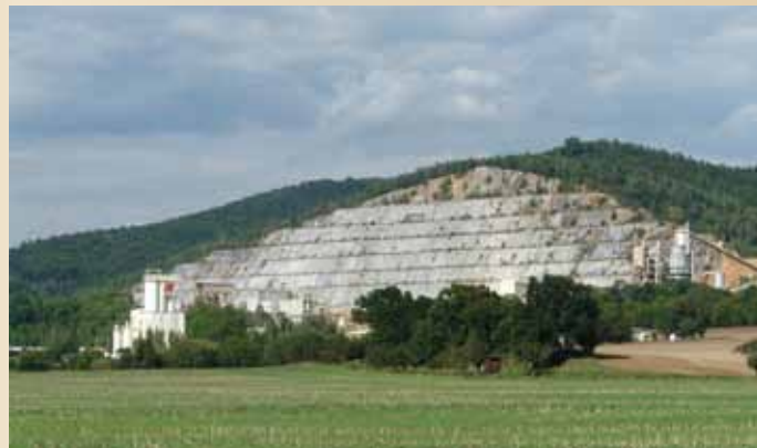
Těžba a výroba vápencových surovin, Vítošov. Lom s přesnými odstřehy na etážích metodou presplit dodává surovinu zejména pro výrobu vápna.
