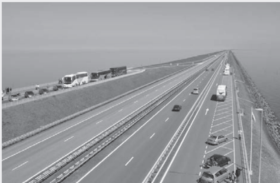
Dopravní stavby přinášejí násobné efekty a zušlechťují krajinu
