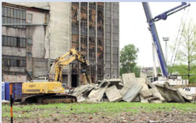
Demolice budovy skipu výdušné jámy v areálu bývalého dolu Paskov – Ostrava přichází o technickou památku
