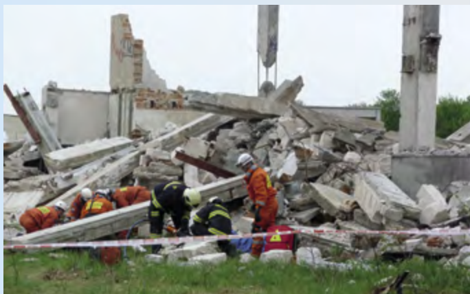
Zajímavé torzo skeletu po odstřelu. Výztuž ohýbaného prvku dokonale funguje na vzpěr. V Brně v areálu ERGON byl proveden odstřel masivní železobetonové konstrukce za účasti odborníků z ČKAIT.
