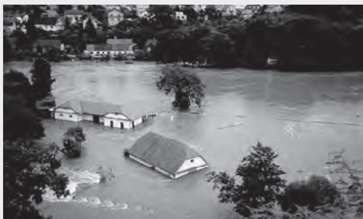
Hluboká nad Vltavou při povodních v roce 2002, škody na majetku byly vysoké
