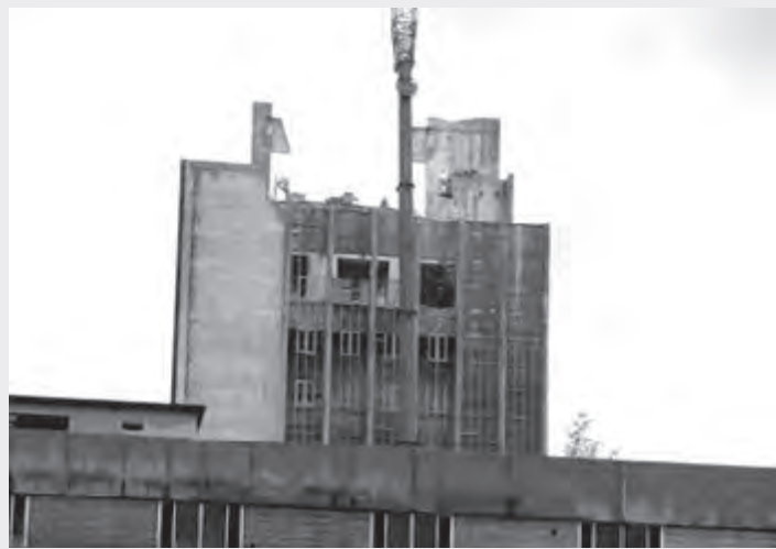
Postupné rozebírání budovy. Technologické postupy a nové stroje nacházejí stále častější uplatnění.
