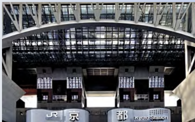
Odborná exkurze do Japonska – nádraží v Kjótu, charismatická, hojně navštěvovaná stavba
