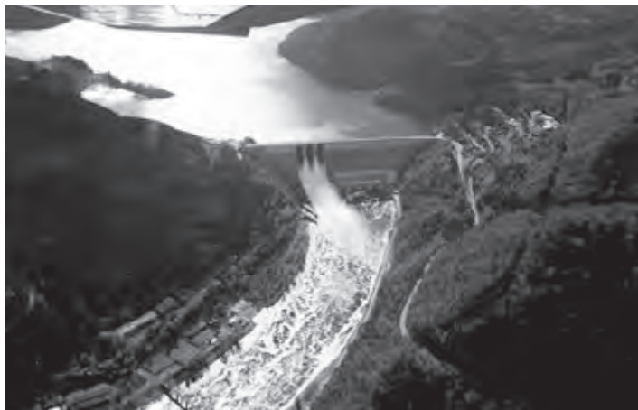
Vodní dílo Orlick. Povodňová vlna v roce 2002 odváděná přelivy v hrázi nádrže poškodila dno vývřiště.
