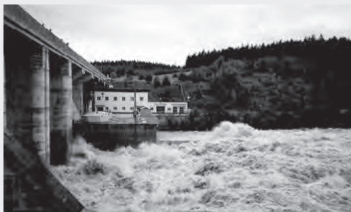
Vodní dílo Hněvkovice – vrchol povodňového průtoku v roce 2013 byl převeden přelivem v hrázi nádrže bez vnějších škod
