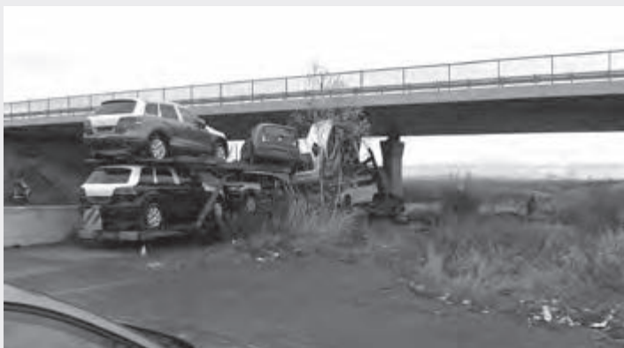
Do mostního pilíře narazil tahač dopravující na návěsu devět osobních aut
