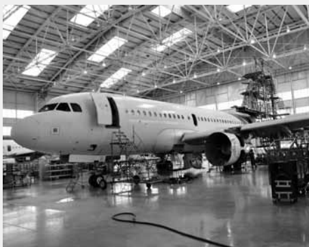
Oprávněnská hala letadel v Mošnově (foto: Ing. arch. Karel Novotný)
