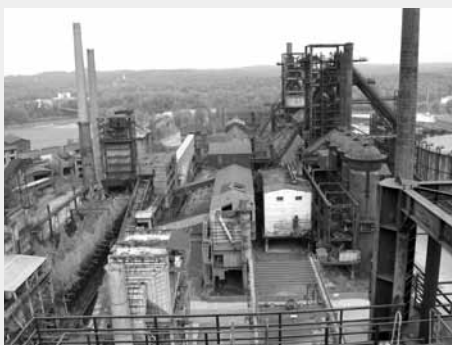
Dolní oblast Vítkovice – vysoké pece (foto: Ing. arch. Karel Novotný)
