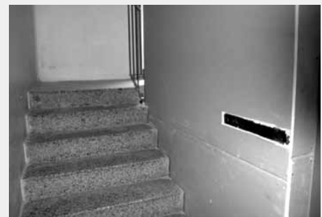
Stěna výtahové šachty po opravě a bez zábradlí
