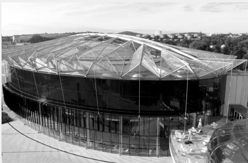
„Voliéra“ na střeše Kongresového centra Zlín zakrývá motory klimatizace a vzduchotechniky
