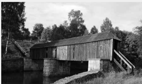
Dřevěný most v Lenoře
