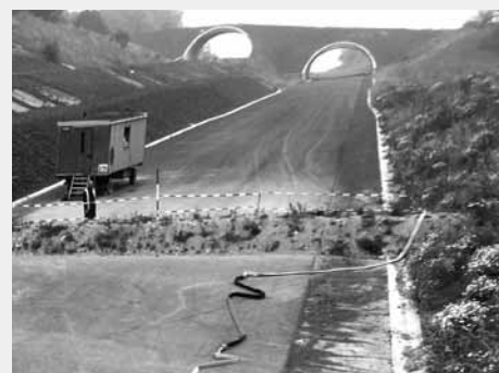
Rozestavěná dálnice D8
