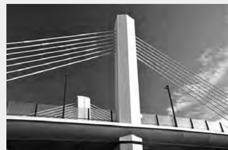
Most na silnici I/67 přes Bohumínskou stružku v úseku Skrečůň – Bohumín
