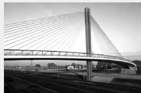
Most na cyklistické stezce Ostravská přes dálnici, silnici I/67 a odvodňovací příkop
