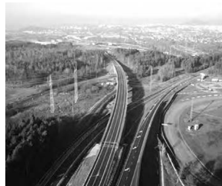
Estakáda přes trať a komunikace, přeložka silnice I/9 MÚK Sosnová
