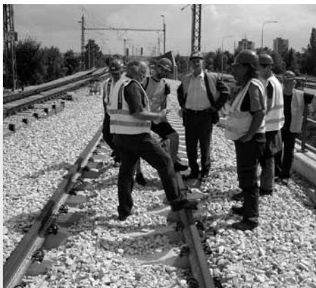
Stavba železničního koridoru v úseku České Budějovice – Nemanice I
