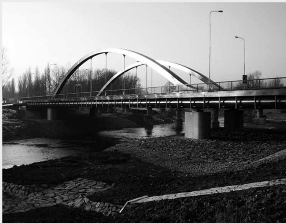
Oceněná Stavba roku Moravskoslezského kraje 2011 – most přes řeku Olši v Karvině
