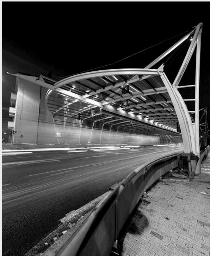
Cena ČKAIT 2009. Nosná ocelová konstrukce protihlukového tunelu v Hradci Králové.
