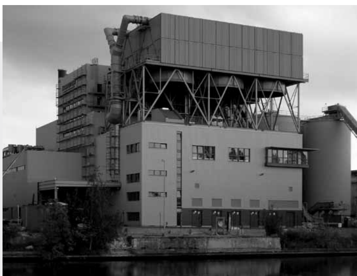
Cena ČKAIT 2006. Provozní soubor vzduchem chlazené kondenzace pro parní turbínu 20 MW v Bertíně.
