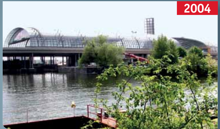
Berlín, Lehrter Bahnhof, v době stavby největší staveniště ve střední Evropě
