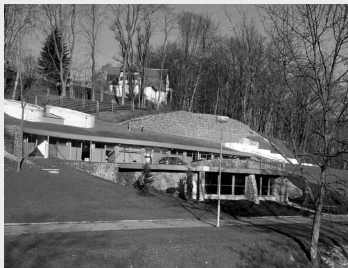
Cena ČKAIT 2008. Podzemní čistírna odpadních vod v Náměšti nad Oslavou.
