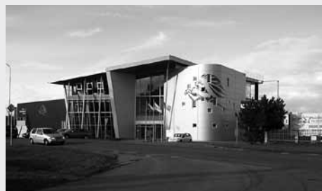
Nově otevřené Energi centrum společnosti Kingspan v Hradci Králové
