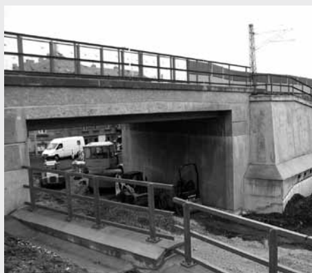
Most Skuherského a navazující opěrné zdi
