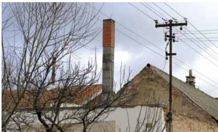
Nestabilizovaný komín, riziko ztráty stability
