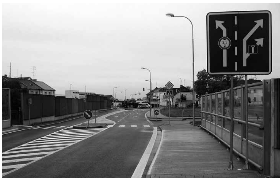
Zanášadražní komunikace, etapa 2.1 – dokončená stavba
