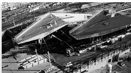
Výstavba centrálního nádraží ve Vídni – pohled z ptací perspektivy
