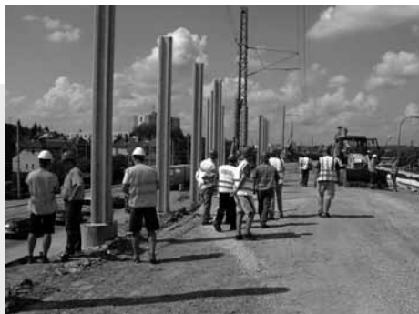
Modernizace trati České Budějovice – Nemanice
