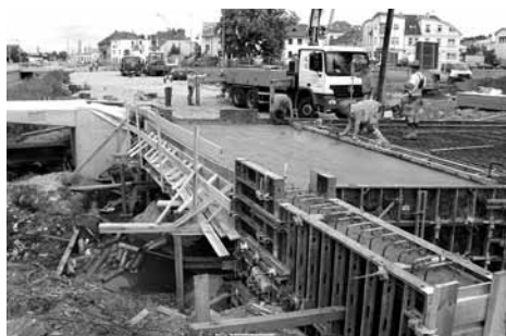
Zanádražní komunikace, etapa 2.1 – most přes drobný vodní tok – betonáž mostovky
