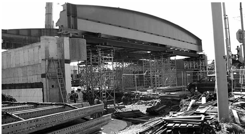
Most Pekárenská – osazování nosné konstrukce mostu
