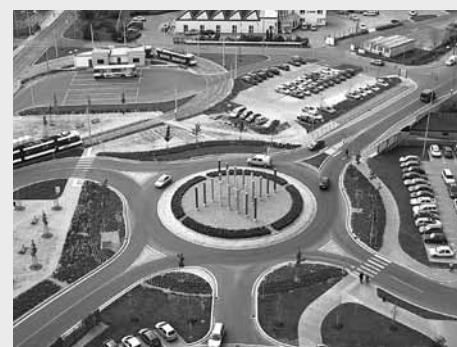
Přednádraží v Olomouci – stav po ukončení III. etapy v roce 2006
