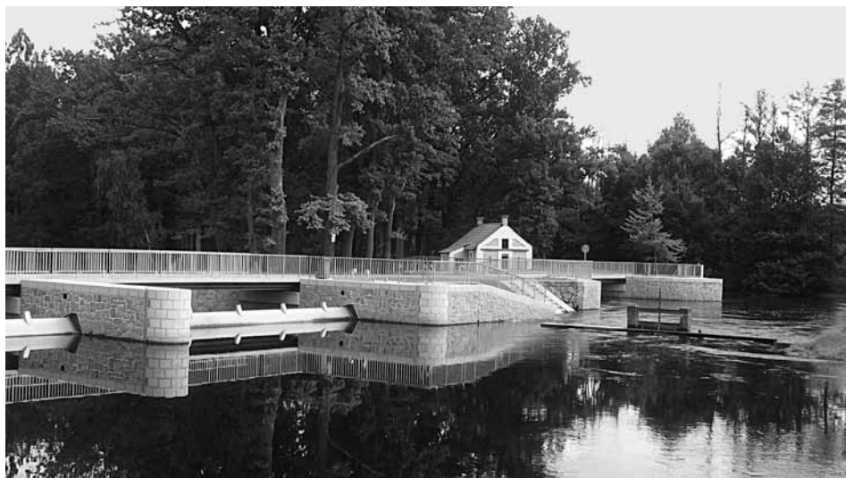
Rozdělovací objekt Novořecké splavy – jez na řece Lužnici, letošní vítěz soutěže PRESTA
