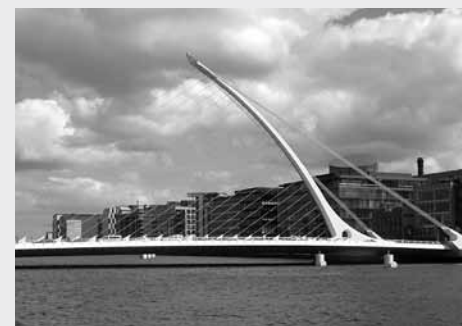
Otočný most přes řeku Liffey v Dublinu – lanová konstrukce ve tvaru harfy
