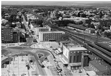
Přednádraží v Olomouci – stav po ukončení IV. etapy v roce 2010
