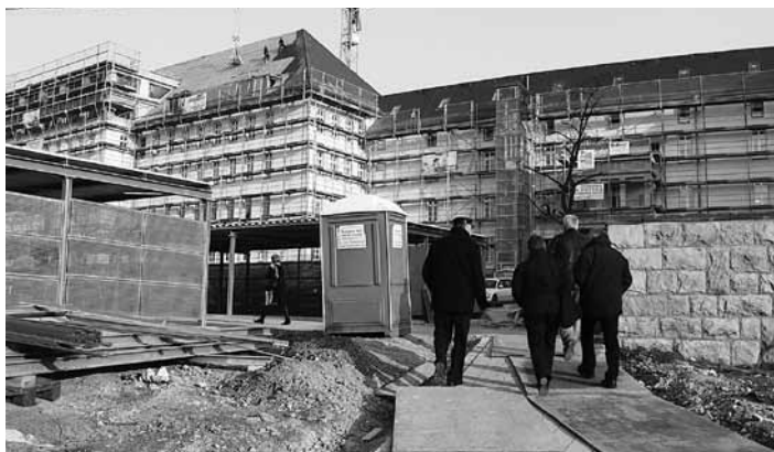
Z návštěvy Bavorské inženýrské komory, foto z exkurze – konverze bývalé vojenské nemocnice Wehrmachtu a poté armády USA ve Würzburgu na bydlení
