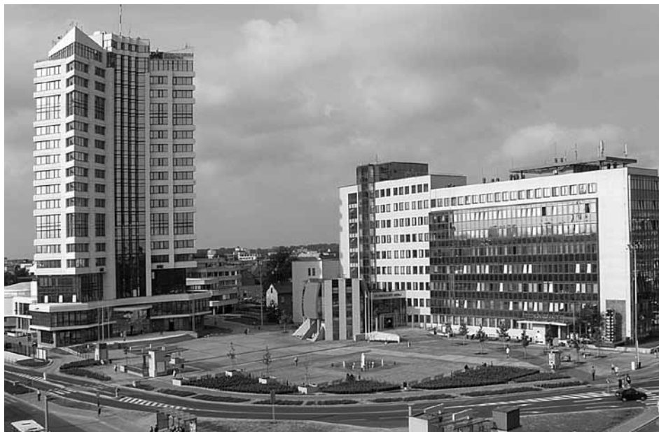
Přednádraží v Olomouci – stav po ukončení I. a II. etapy v roce 2002
