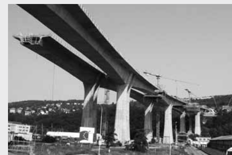
Výstavba nosné konstrukce – pohled mostu
