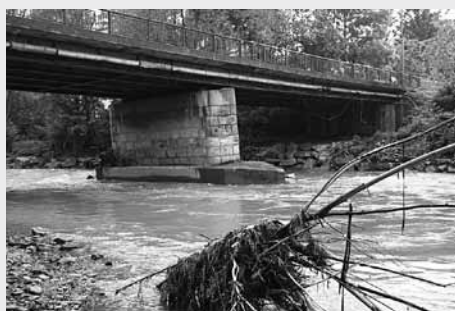
Nakloněný pilíř mostu přes řeku Ostravici v obci Baška
