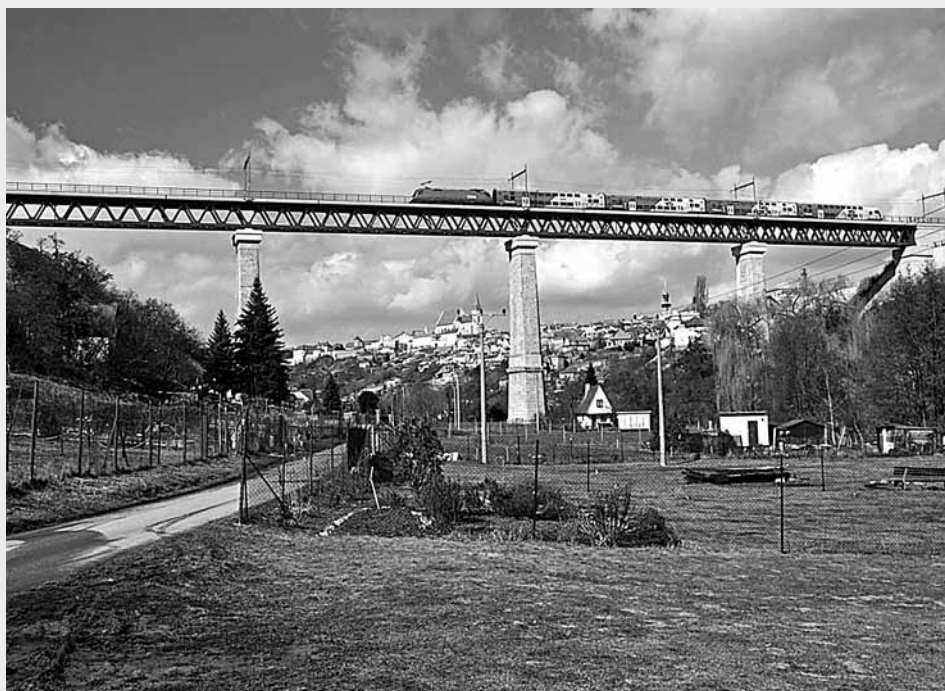
Znojemský železniční viadukt
