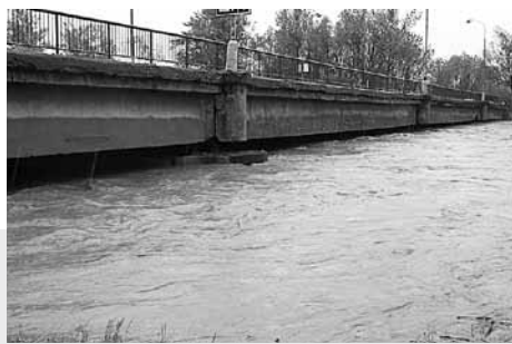
Most přes řeku Olši v Karviné
