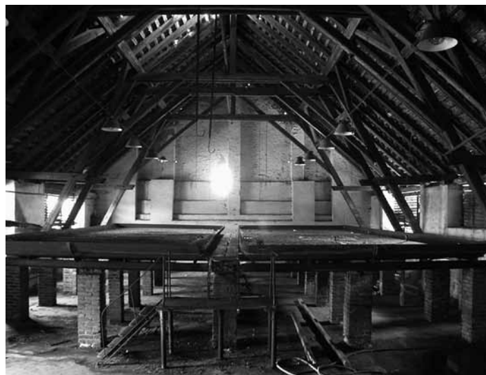
Krov chladicího štoku pivovaru v Kostelci nad Černými lesy
