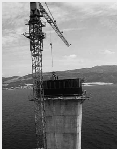
Rozestavěný most Kopno – Pelješac
