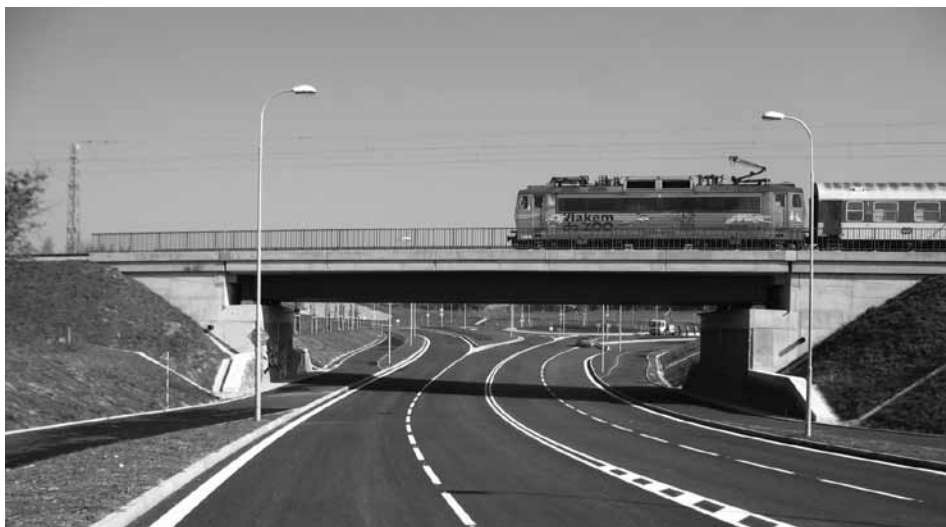
Silnice I-34 – most na železniční trať
