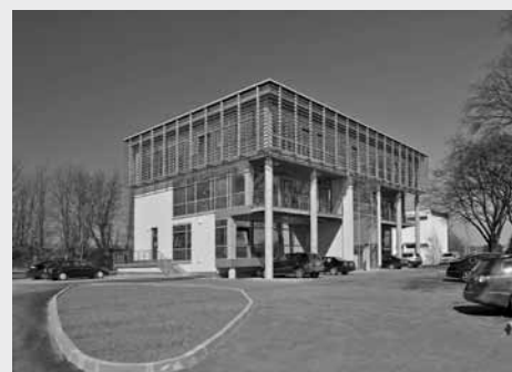
Administrativně-provozní budova mlékárny Hlinsko
