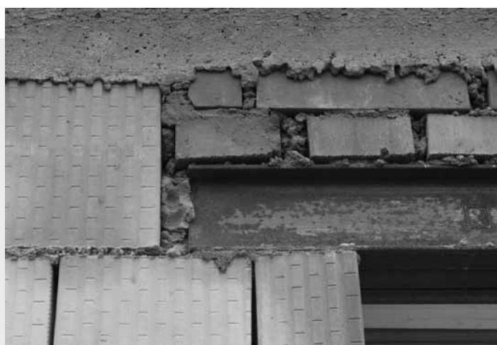
Uložení ocelového válcovaného nosníku na zdivu a použití cihel různých vlastností
