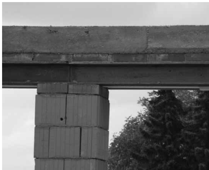
Uložení překlada přímo na neprovázané zdivo
