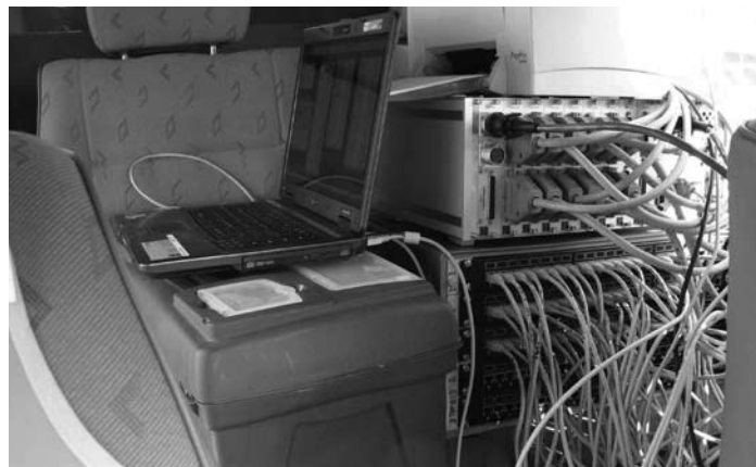
Měřicí ústředna pro měření sil v táhlech konstrukce tunelu
