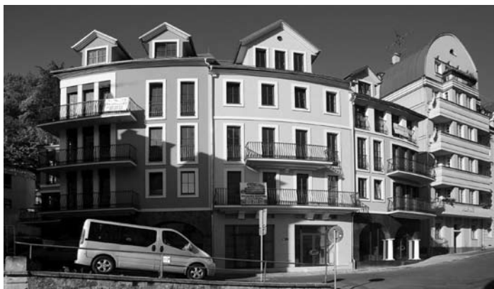
Polyfunkční dům Zámecký vrch
