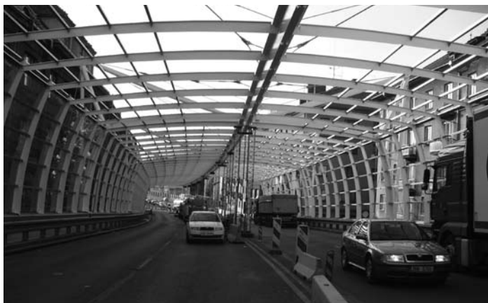
Ocelová konstrukce protihlukového tunelu, montážní podpory páteřního nosníku
