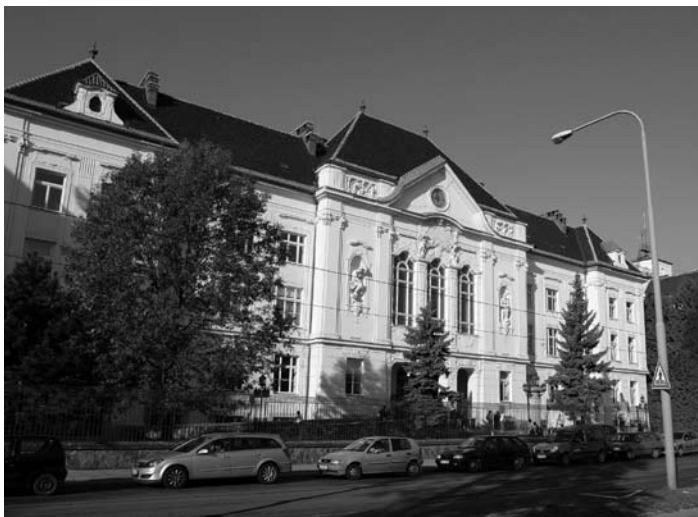
Budova Fakulty stavební VUT v Brně
