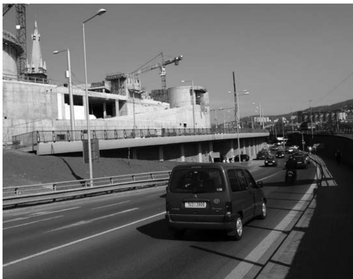
Pohled na jižní průčelí budovaného centra FORUM od ulice Malá Hradební v Ústí nad Labem
