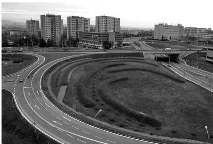
Křižovatka Hradecká–Purkyňova v Brně, rampy II. etapa – Stavba roku Jihomoravského kraje 2008
