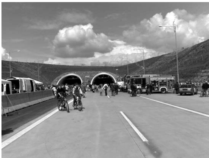
Klimkovický tunel na dálnici D 47
