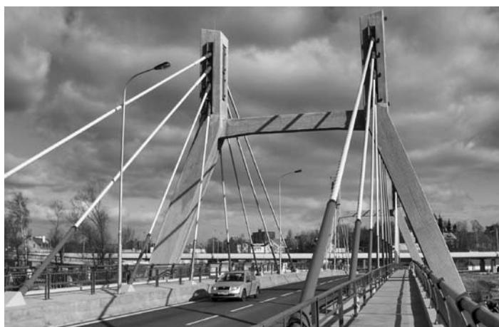
3. místo – Most přes Ohři – Tuhnice
