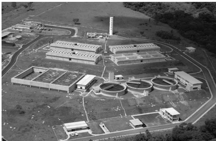
Čistírna odpadních vod pro 210 tisíc obyvatel v Campinas, Brazílie
