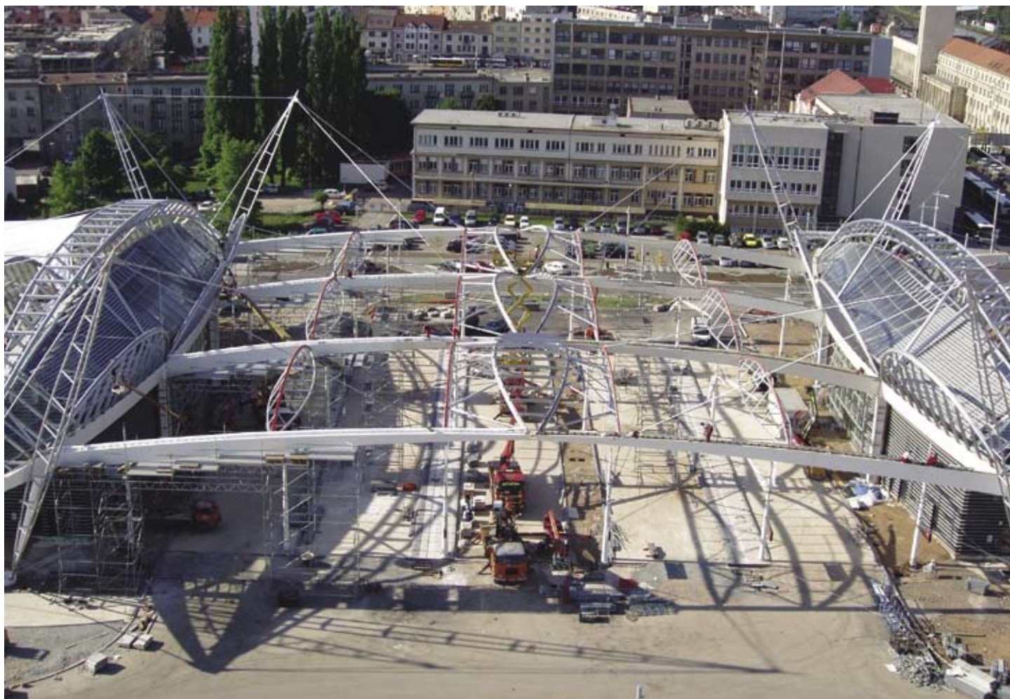
Pohled na ocelovou konstrukci zastřešení Terminálu hromadné dopravy v Hradci Králové
