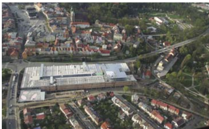
Výstavba CITY PARK v Jihlavě
