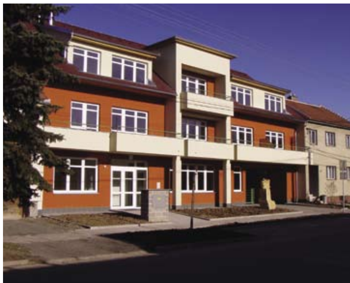
Integrovaný dům s chráněnými byty v Podolí Investor: Obec Podolí Projektant: Ing. arch. Zdeněk Tihelka Zhotovitel: Skanska CZ, region Brno, s.r.o.
