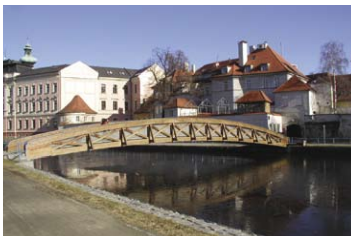
Jednou ze tří lávek, které Ing. Václav Mach, předseda ČKAIT, pro České Budějovice vyprojektoval, je dřevěná lávka přes slepé rameno Malše
