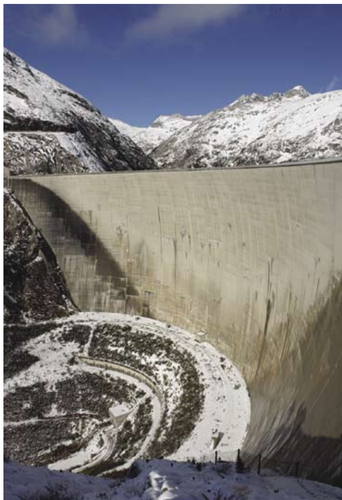
Sanační stavby na patě přehrad Köllnbreinsperre (foto Ing. Miroslav Loutocký).
