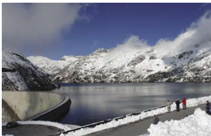
Hlavní téma exkurze Korutany přehrada Köllnbreinsperre (foto Ing. Miroslav Loutocký).
