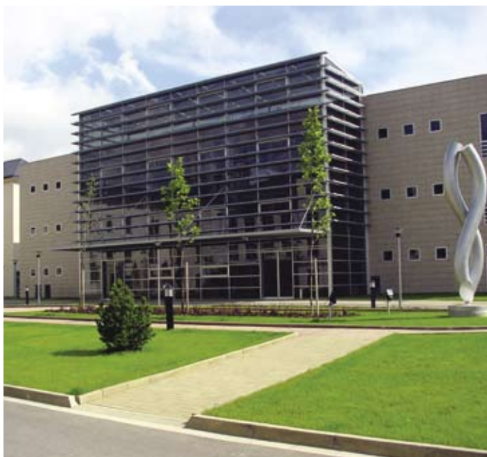
Krajský úřad Jihlava – stavba roku Vysočiny 2007.
