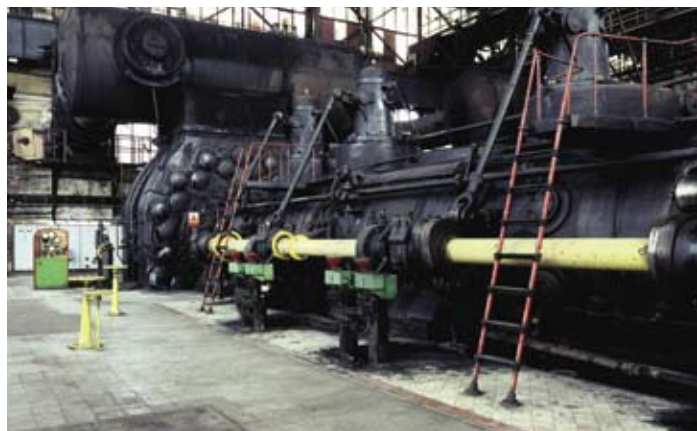
Energetická ústředna v Dolní oblasti Vítkovic. Autor: Ladislav Drezdowicz.
