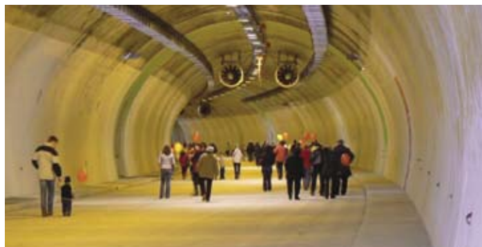
Prohlídka stavby tunelu v Klimkovicích na dálnici D 47.
