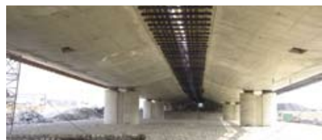
Stavba zavěšeného mostu přes Odru pomocí výsuvné skruže s horním nosným systémem (foto SKANSKA DS)
