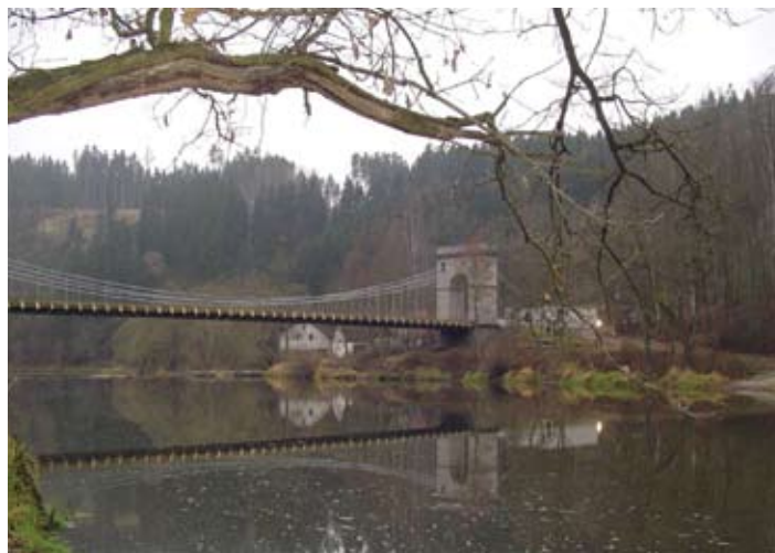
Most byl ubráněn a uveden do provozu
