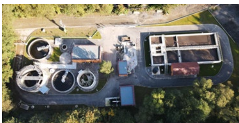
1. Intenzifikace ČOV Kamenice Přihlašovatel: Ing. Ondřej Kybast, stavbyvedoucí a přípravitel, oblast Praha
