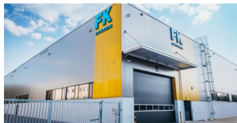
4. Demolice a výstavba nové výrobní haly FK systém Přihlašovatel: Ing. Petr Konvalina, hlavní stavbyvedoucí, oblast Brno
