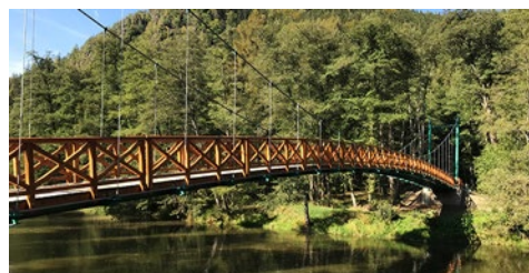
3. Lávka přes řeku Ohři ve Svatošských skalách Přihlašovatel: Ing. Jan Procházka, vedoucí projektant, oblast Karlovy Vary
